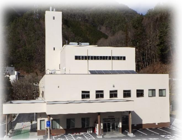
木曾クリーンセンター 可燃ごみ処理場
